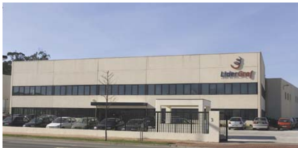
Aspecto geral das novas instalações.
