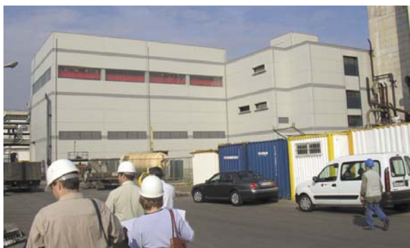
Edifício TV, Portucel Viana. Vista do edifício onde está instalada a nova turbina de vapor de 26 MW da Portucel Viana, contíguo à área reservada para a futura central de cogeração com turbina a gás de 30 MW.
