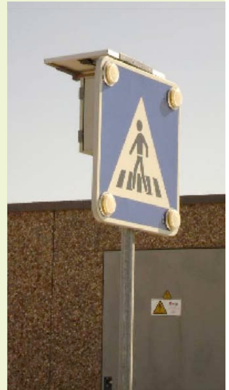
Iluminação por lâmpadas LED
